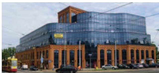
Rys. 1. Przykład kontrastującego połączenia architektury szklanej z zabytkową tkanką starego obiektu pofabrycznego w Łodzi
