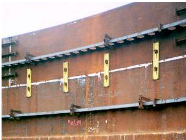
Rys. 4. 5. Usztywnienia montażowe
