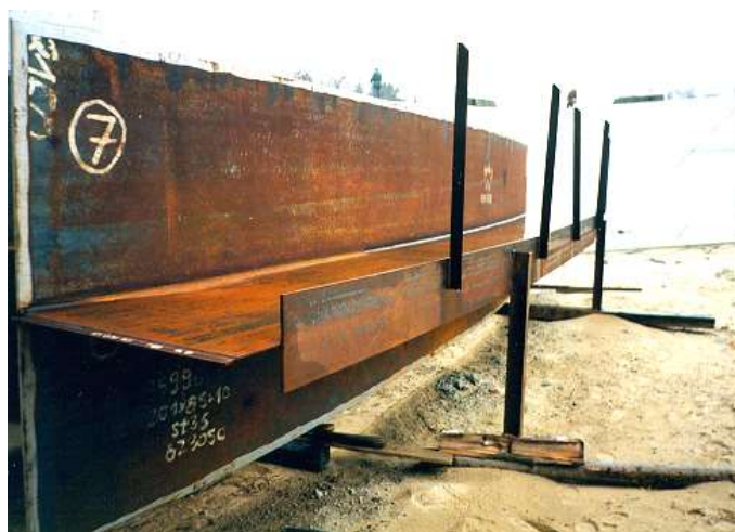
Rys. 4. 10. Prefabrykat ostatniego pierścienia płaszczu
