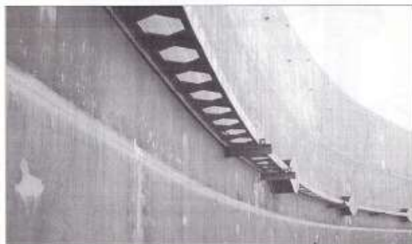
Rys. 6. Pierścień montażowy stosowany w celu zapewnienia prawidłowego kształtu płaszczu zbiornika
