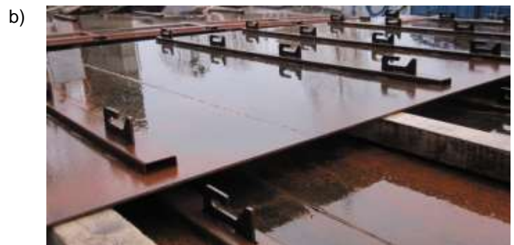
Rys. 9. Przykład zastosowania okładziny ze stali typu Cor-Ten o podwyższonej odporności na warunki atmosferyczne na budynku ECS w Gdańsku (DK) a) fragment elewacji budynku, b) składowana blacha elewacyjna z widocznymi zawieszami
