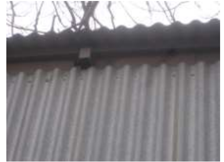
Rys. 6. Stalowa blacha ocynkowana na ścianach i dachu obiektu magazynowego (DK)
