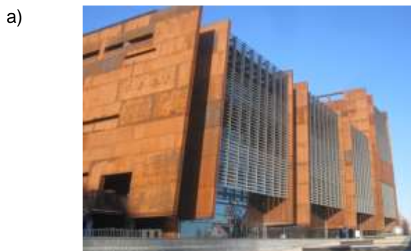
Rys. 9. Przykład zastosowania okładziny ze stali typu Cor-Ten o podwyższonej odporności na warunki atmosferyczne na budynku ECS w Gdańsku (DK) a) fragment elewacji budynku, b) składowana blacha elewacyjna z widocznymi zawieszami
