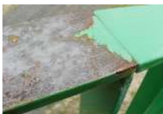
Rys. 3. Elementy barier wykonane bez powłoki cynkowej i z objawami korozji typowymi dla czarnej stali węglowej Fig. 3. Elements of barriers made without the zinc coating and corrosion symptoms typical black carbon steel
