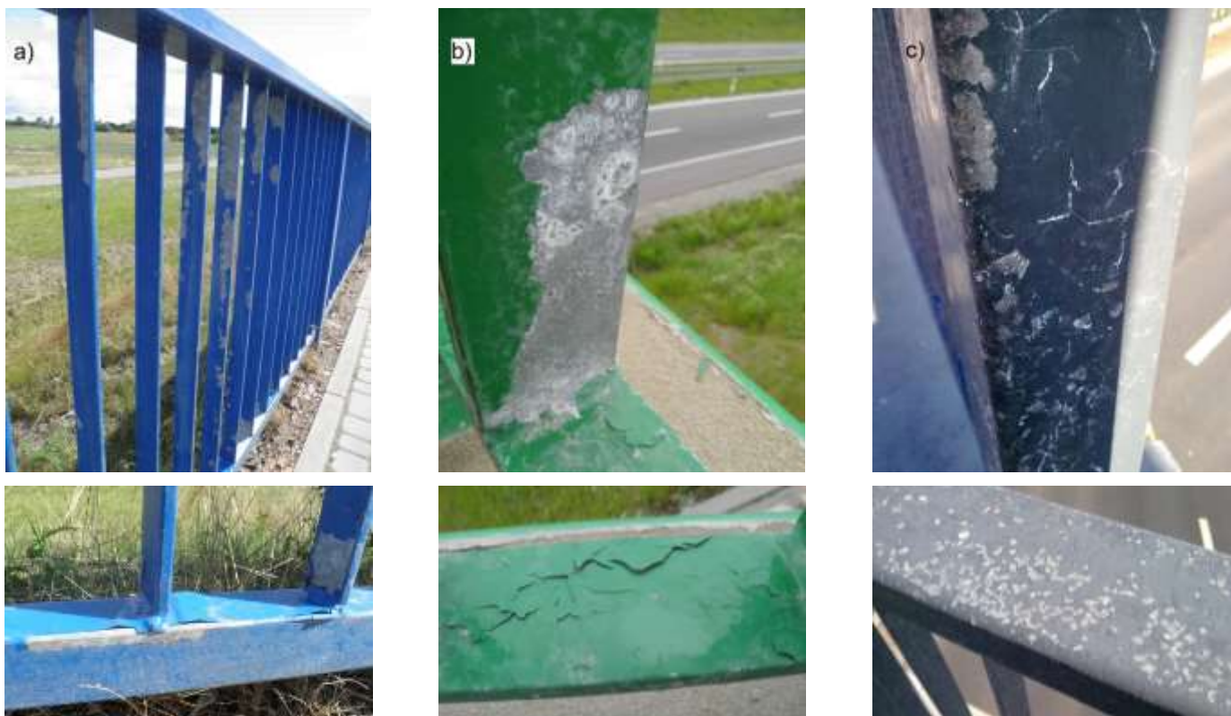
Rys. 1. Przykłady stanu powłok malarskich na elementach stalowych ocynkowanymi zanurzeniowo na trzech wybranych wiaduktach drogowych wykonanych nad: a) autostradą [3], b) drogą krajową [3], c) obwodnicą miasta [4],
