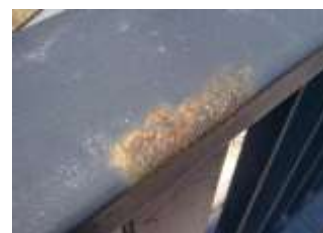
Rys. 3. Elementy barier wykonane bez powłoki cynkowej i z objawami korozji typowymi dla czarnej stali węglowej Fig. 3. Elements of barriers made without the zinc coating and corrosion symptoms typical black carbon steel
