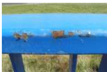
Rys. 3. Elementy barier wykonane bez powłoki cynkowej i z objawami korozji typowymi dla czarnej stali węglowej Fig. 3. Elements of barriers made without the zinc coating and corrosion symptoms typical black carbon steel
