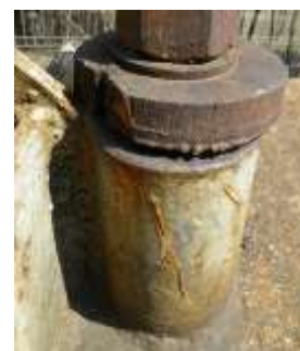
b) stan skorodowania eksploatowanej części spalinowej komina
