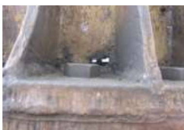
b) stan skorodowania eksploatowanej części spalinowej komina
