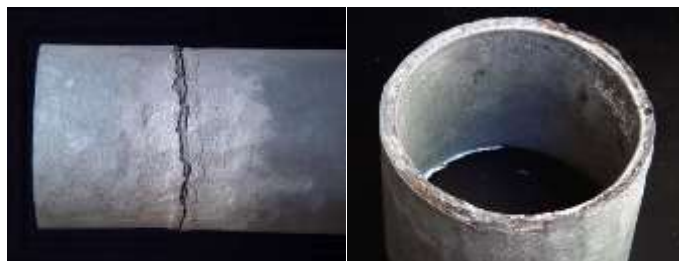
b) zniszczone połączenie rury pasa dolnego
