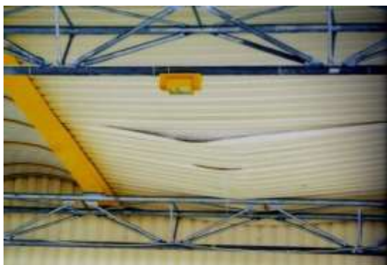
c) załamana blacha pod workiem śnieżnym
