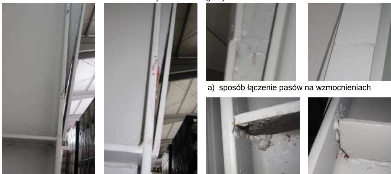
b) przykłady złego wykonania wzmocnienia
