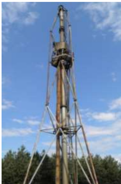
Fot. 8. Widok ogólny obiektu
