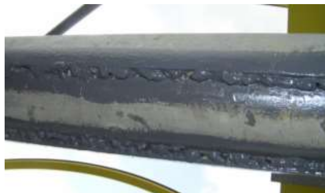
d) sposób naprawy słabych połączeń doczołowych
