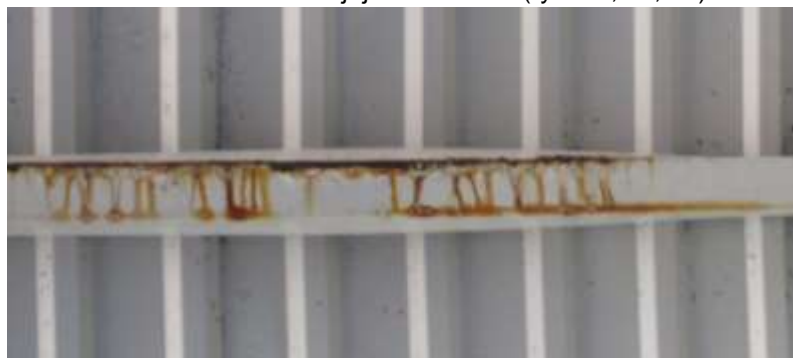
b) rura prostokątna rozsadzony przez zamarzającą wodę
