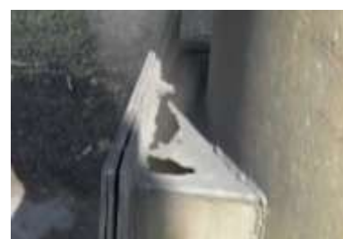
b) stan skorodowania eksploatowanej części spalinowej komina
