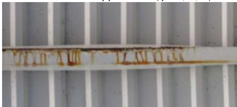
b) rura prostokątna rozsadzony przez zamarzającą wodę
