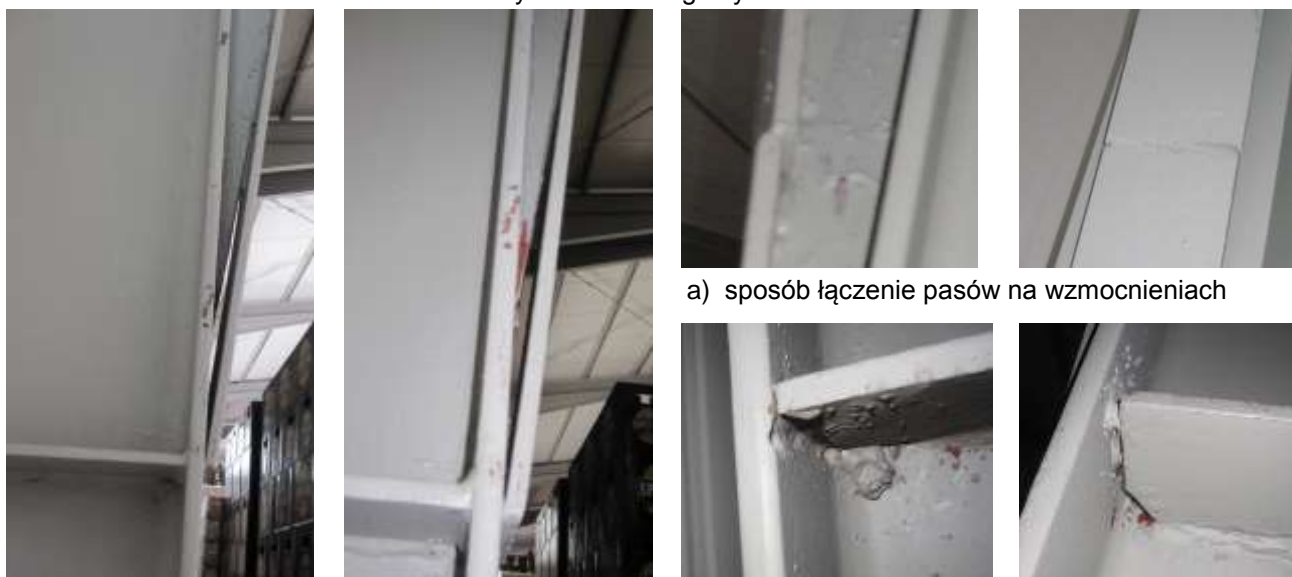
b) przykłady złego wykonania wzmocnienia
