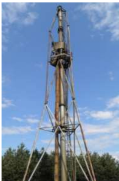
Fot. 8. Widok ogólny obiektu
