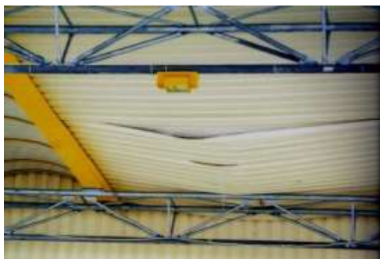
c) załamana blacha pod workiem śnieżnym
