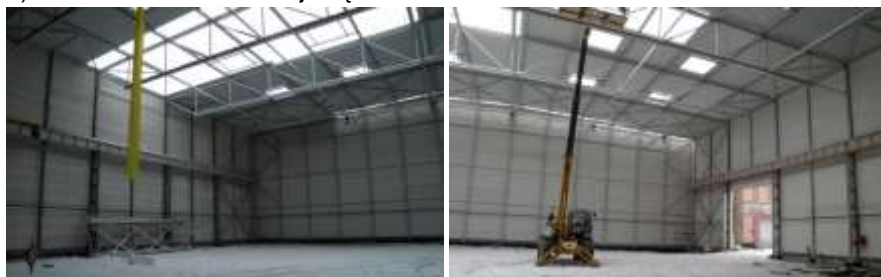
c) widok ogólny wnętrza hali
