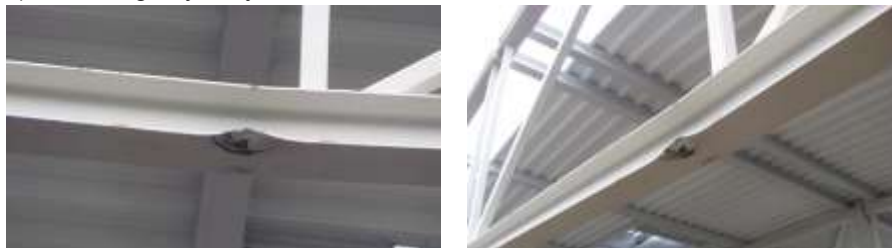
d) miejscowe i globalne deformacje pasa dolnego uszkodzonej kratownicy
