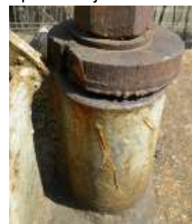
b) stan skorodowania eksploatowanej części spalinowej komina
