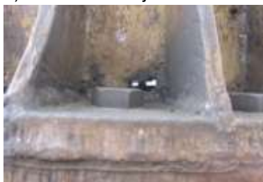
b) stan skorodowania eksploatowanej części spalinowej komina
