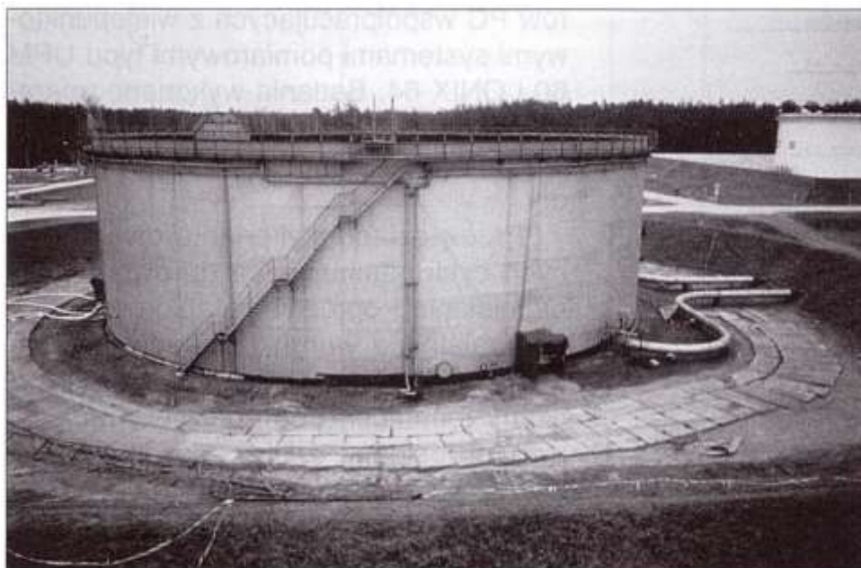
Rys. 2. Widok ogólny zbiornika
