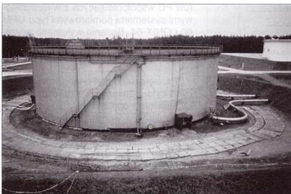
Rys. 2. Widok ogólny zbiornika
