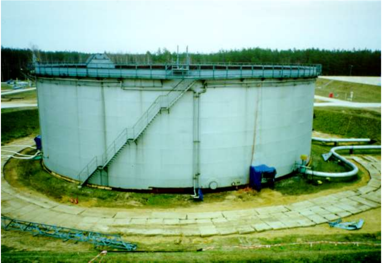
Rys. 2. Widok ogólny zbiornika
