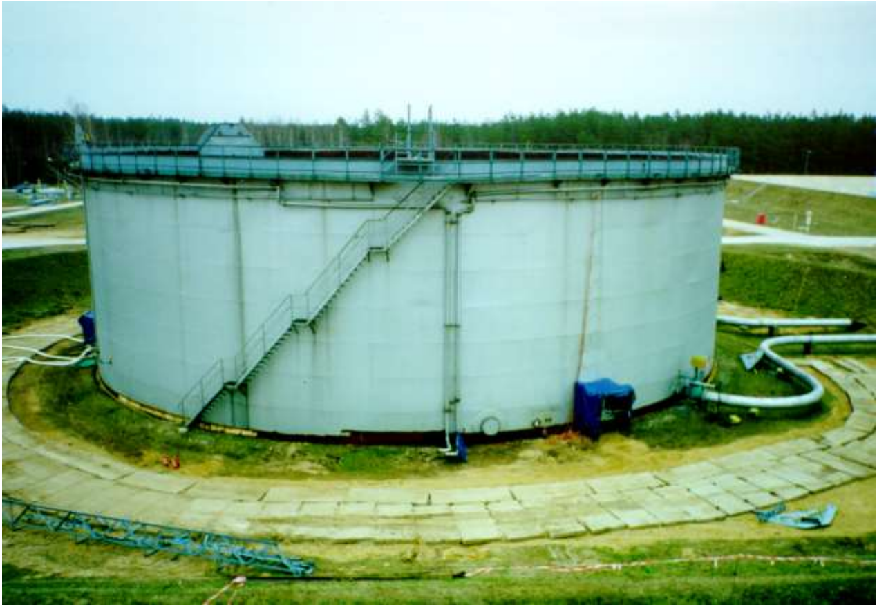
Rys. 2. Widok ogólny zbiornika
